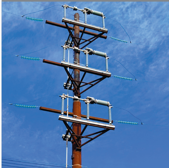
Figura 2. Una vista lateral de la instalación del Circuit-Switcher Mark V.
