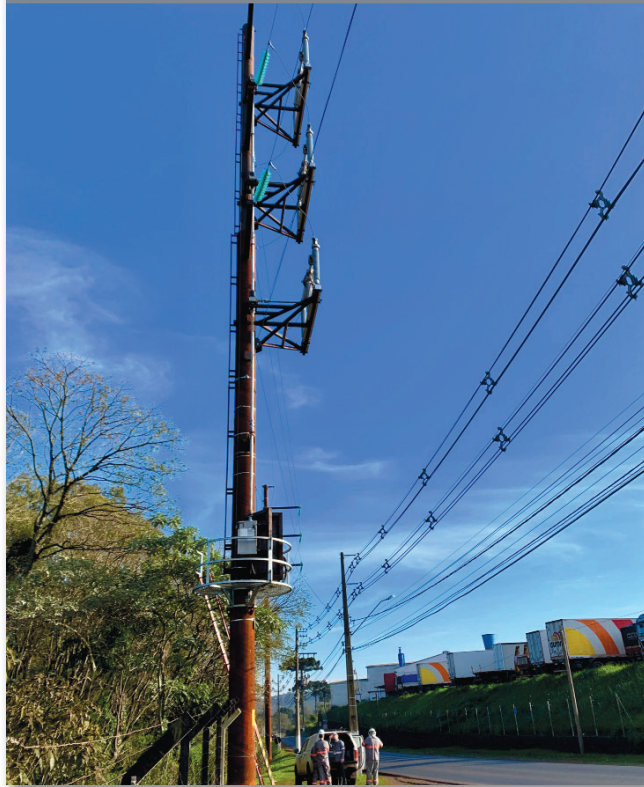
Figura 2. Una vista lateral de la instalación del Circuit-Switcher Mark V.
