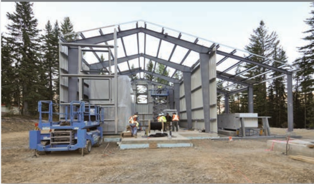
Construcción del sistema de almacenamiento de energía, cubierta prefabricada y controles de la Subestación de Field.
