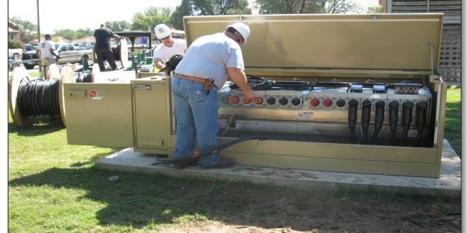
Instalación del Tablero de Distribución Vista® de S&C.
