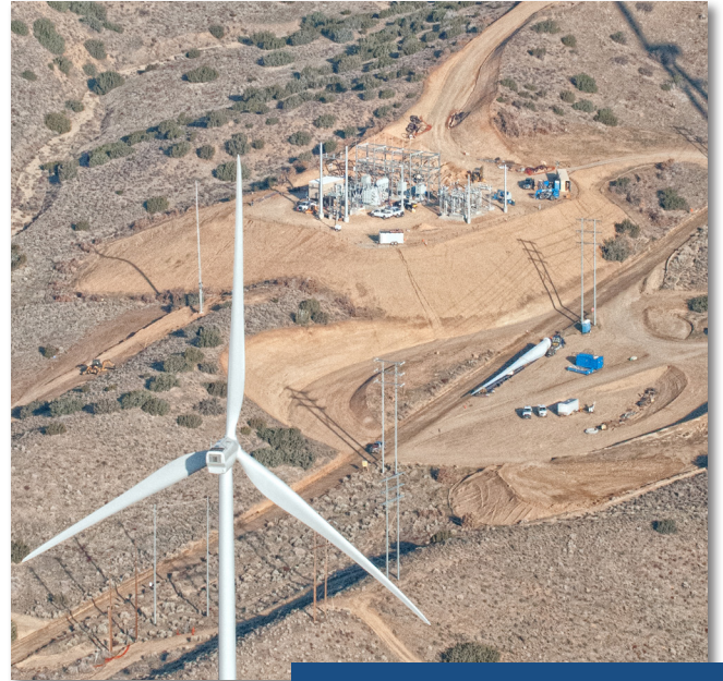
Vista aérea de la subestación de interconexión BT-1.
