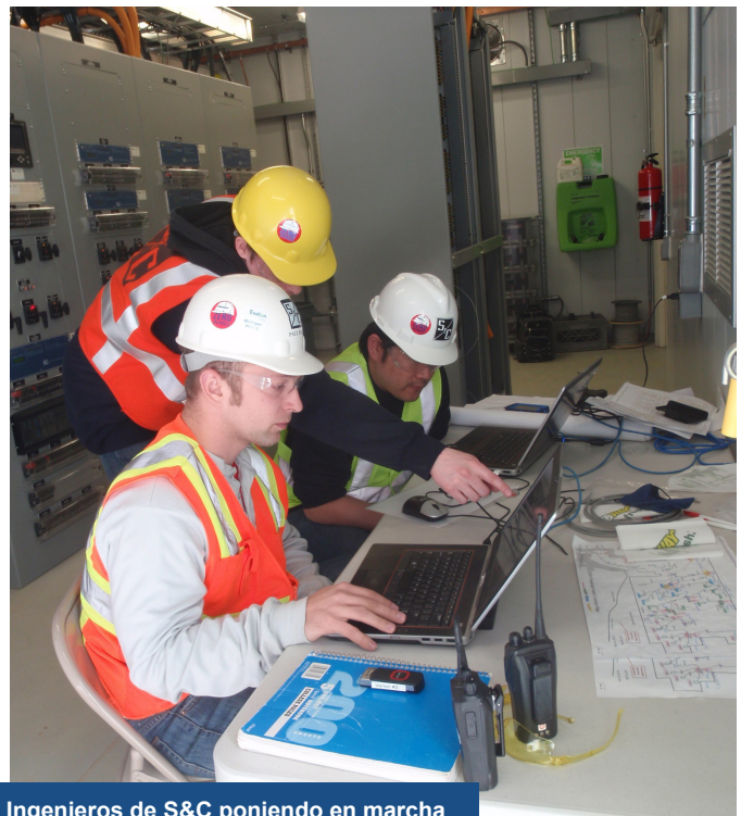
Ingenieros de S&C poniendo en marcha el sistema SCADA del BT-1.
