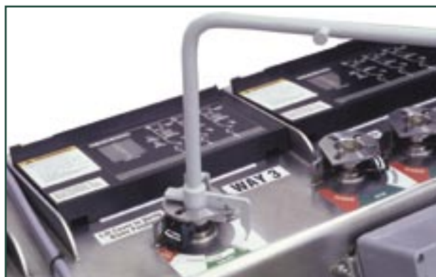
Figura 6. Conectando a tierra el seccionador interruptor de carga (o el interruptor de falla).
