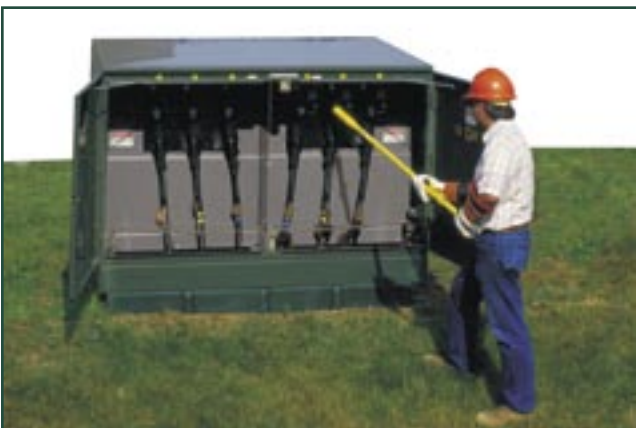
Figura 3. La operación típica en el frente muerto de un equipo puede ser complicada y llevar mucho tiempo.
