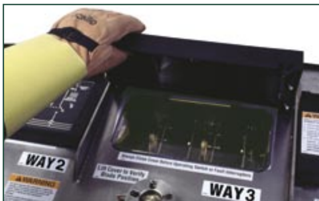
Figura 2. Cubiertas móviles en las mirillas para observar la posición de las cuchillas de seccionamiento del seccionador interruptor de carga o el interruptor de falla.
