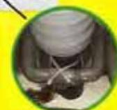
**Los detectores de corriente**, los cuales se incluyen con la función opcional de bloqueo por sobrecorrientes, van montados en cada conductor de la fuente—exactamente debajo del rematador de cables—con el fin de propiciar las condiciones de detección que indiquen que no se debe realizar alguna transferencia de fuente en particular
