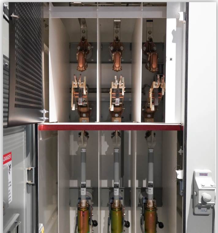
FIGURA 1. Aplicación de los Fusibles de Potencia Tipo SM y SML de S&C en Celdas Cerradas Metálicas y Aparatos Tipo Pedestal de S&C.
