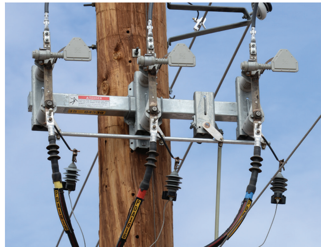
Figura 2. Chave na configuração de montagem Vertical.
