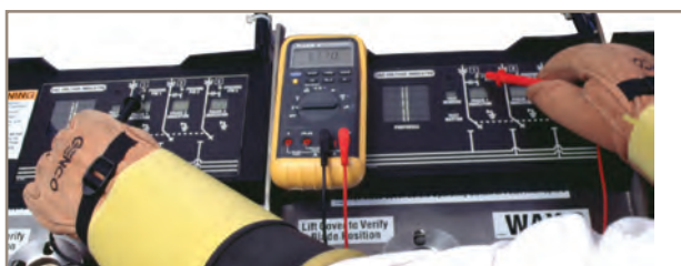
Figura 7. Medição da tensão fase/fase - Fase 1 com Fase 1.
