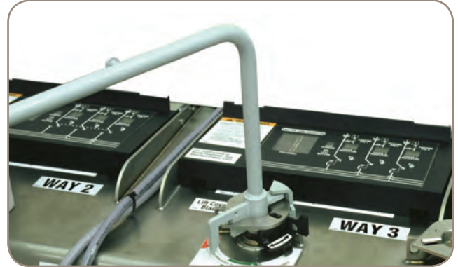
Figura 1. Abrindo um interruptor de carga (ou interruptor de falta).
